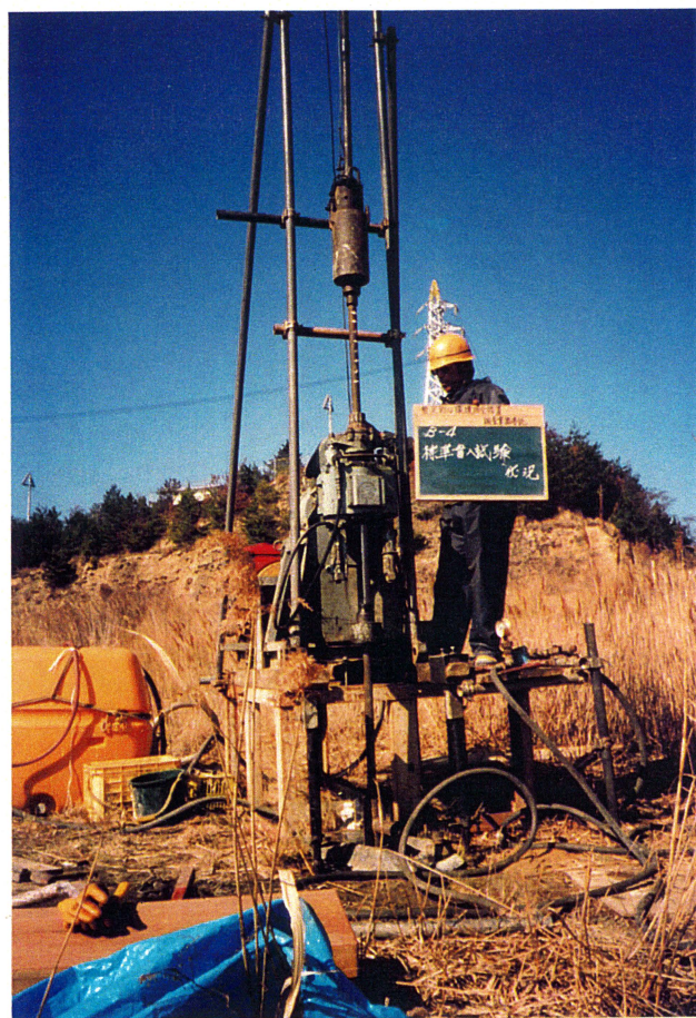
標準貫入試験状況
