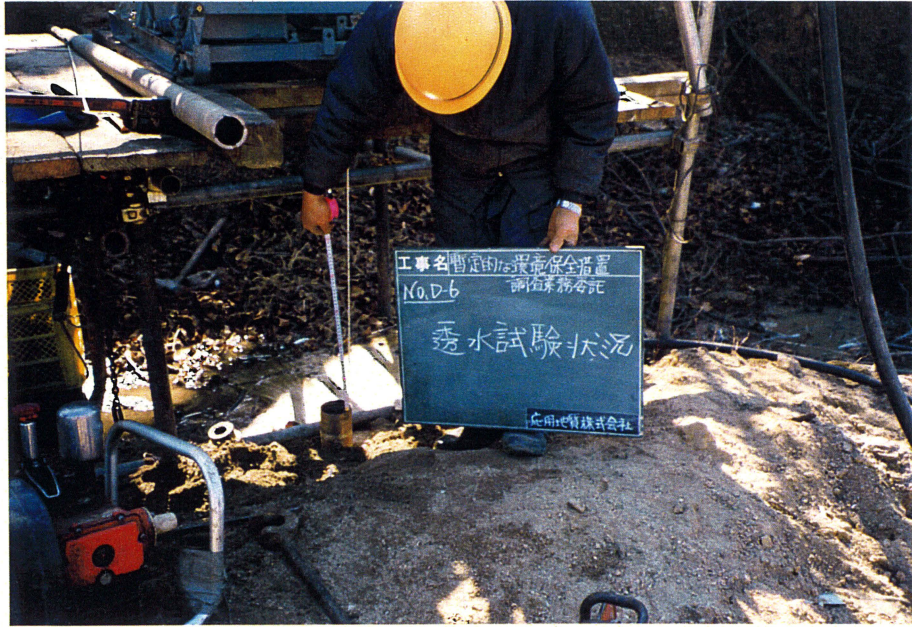
現場透水試験(ケーシング法)状況
