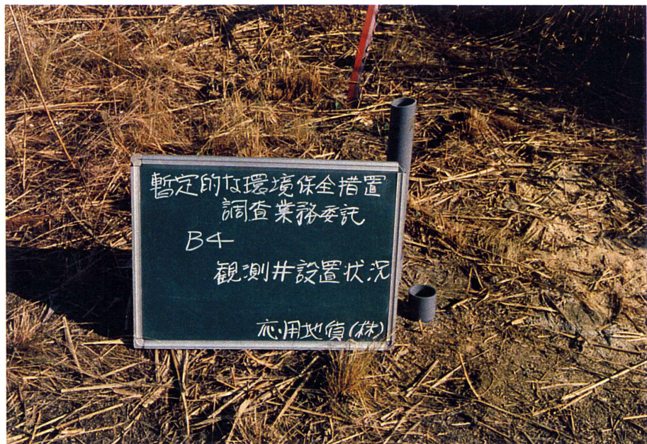
観測井設置状況
