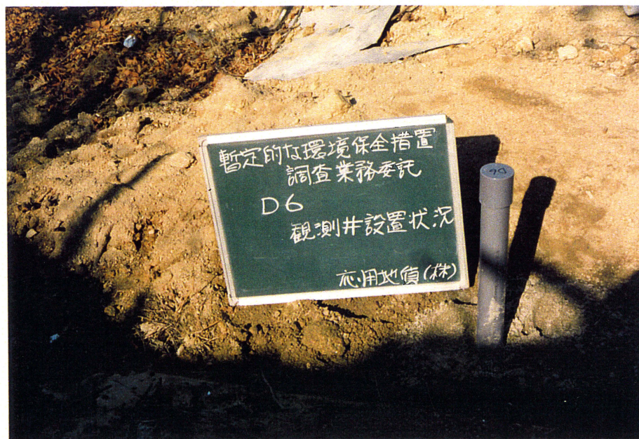
観測井設置状況
